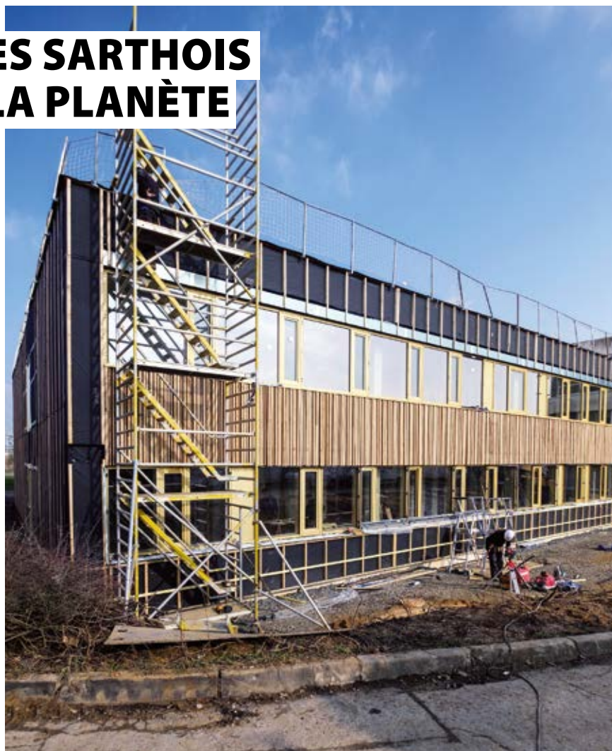
→ À Montval-sur-Loir, le collège de Bercé a bénéficié d'une isolation par l'extérieur et de nouvelles huisseries à haute efficacité énergétique.
