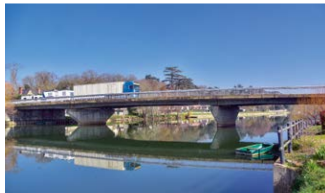
Le pont Joël Le Theule à Sablé-sur-Sarthe. ↓
